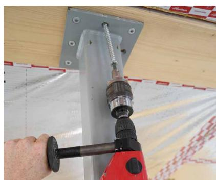
Durante l'avvitamento, il TORQUE LIMITER si disinnesta al valore di coppia impostato.
