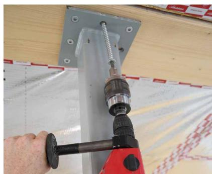
Durante el atornillado, el TORQUE LIMITER se desconecta cuando se alcanza el par de apriete configurado.
