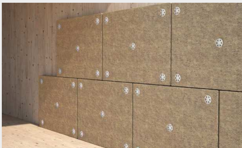
^ Fissaggio di pannelli di isolante per parete con THERMOWASHER e HBS diametro 8 mm.
