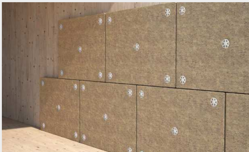
使用 THERMOWASHER 和 8 mm 直径的 HBS 固定墙壁隔热板。
