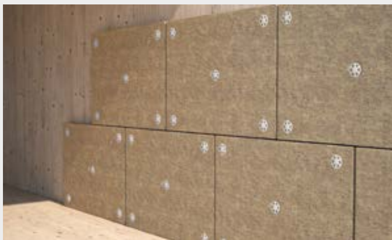
Fixovanie izolačných panelov na stenu pomocou THERMOWASHER a HBS s priemerom 8 mm.
