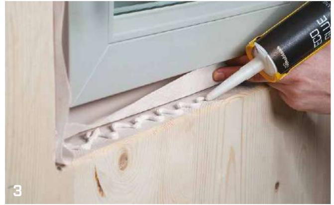
REALIZAR EL SELLADO CON EL CERRAMIENTO YA INSTALADO
